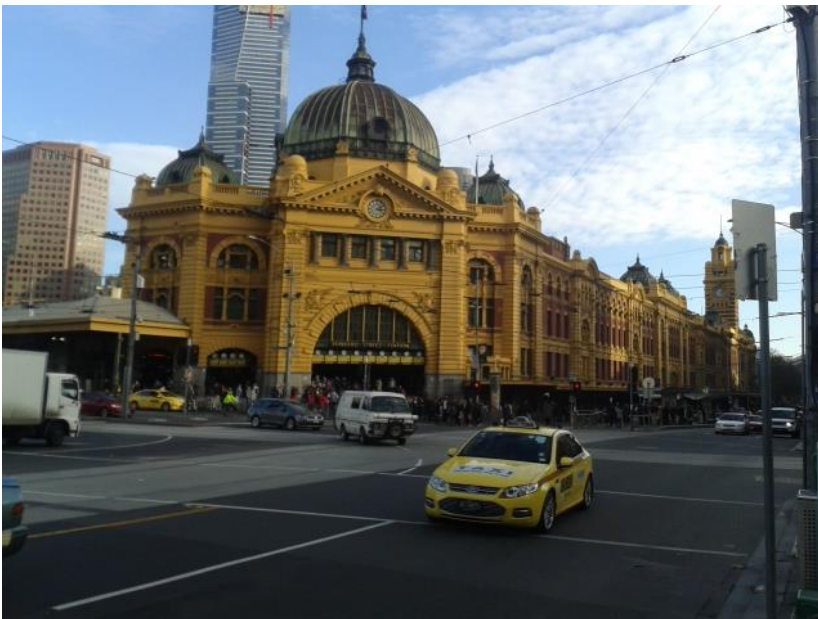
Flinders Station; Bahnhof und eines der imposantesten Gebäude Melbournes
