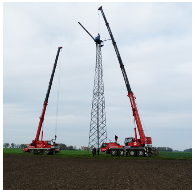
Abb. 2: Abbau der Anlage in Wildeshausen
