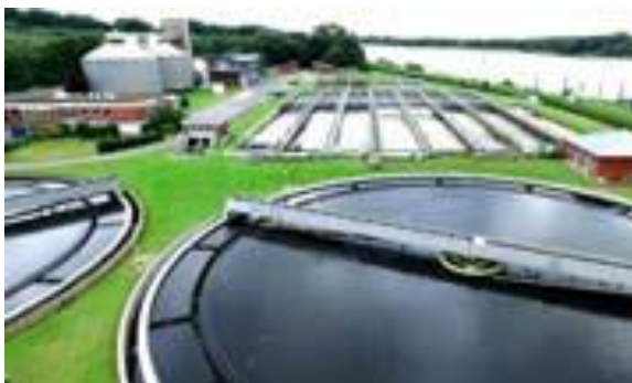
Abb. Kläranlage Seehausen
