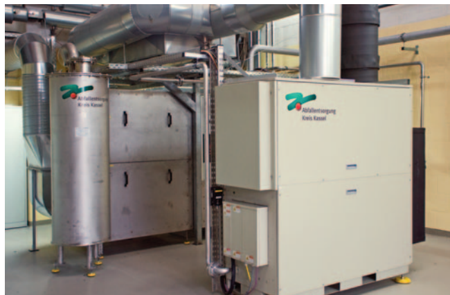
Energieerzeugung: Mikrogasturbine
