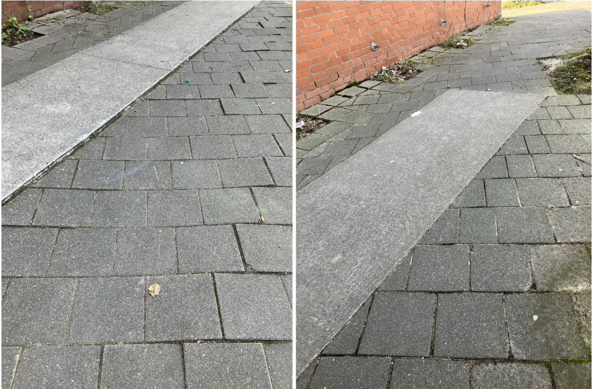
Bild links: Verlegte Bodenplatten mit Stolperkante, Bild rechts: reparierte Bodenplatte mit glatter Kante wie benachbarte Bodenebene
