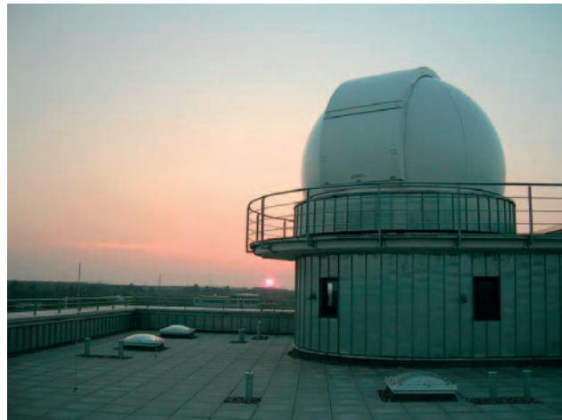
Astronomische Kuppel auf dem NW1 mit untergehender Sonne. In der Kuppel befindet sich der Sonnensucher der das Sonnenlicht in das Spektrometer einkoppelt.
