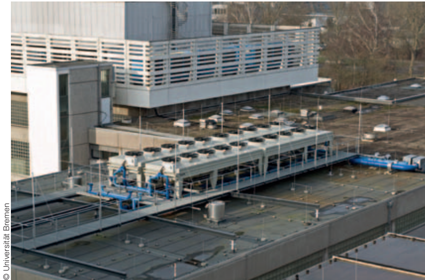
Rückkühler der Freikühlanlage auf dem Dach des Green-IT-Housing-Centers
